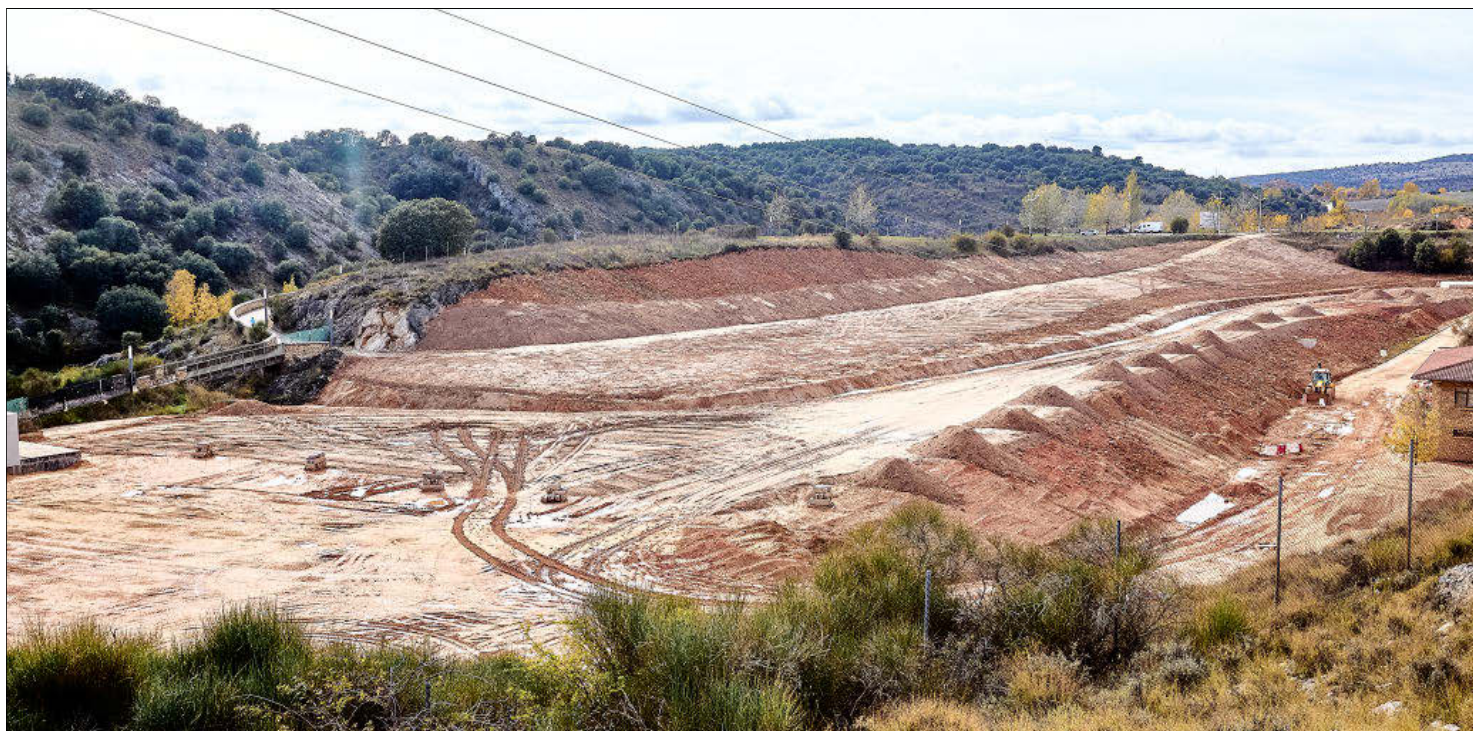
Estado que presenta actualmente la parcela donde se ubicaba la vieja depuradora de Soria y que se está transformando en una zona verde. MONTESEGUROFOTO
